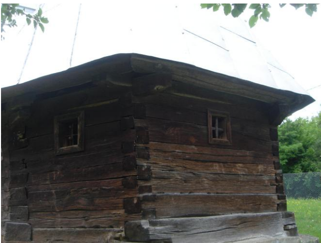
Latura sudică a bisericii “pansată” și ea cu fișii de metal, pînă la vremuri mai bune.
