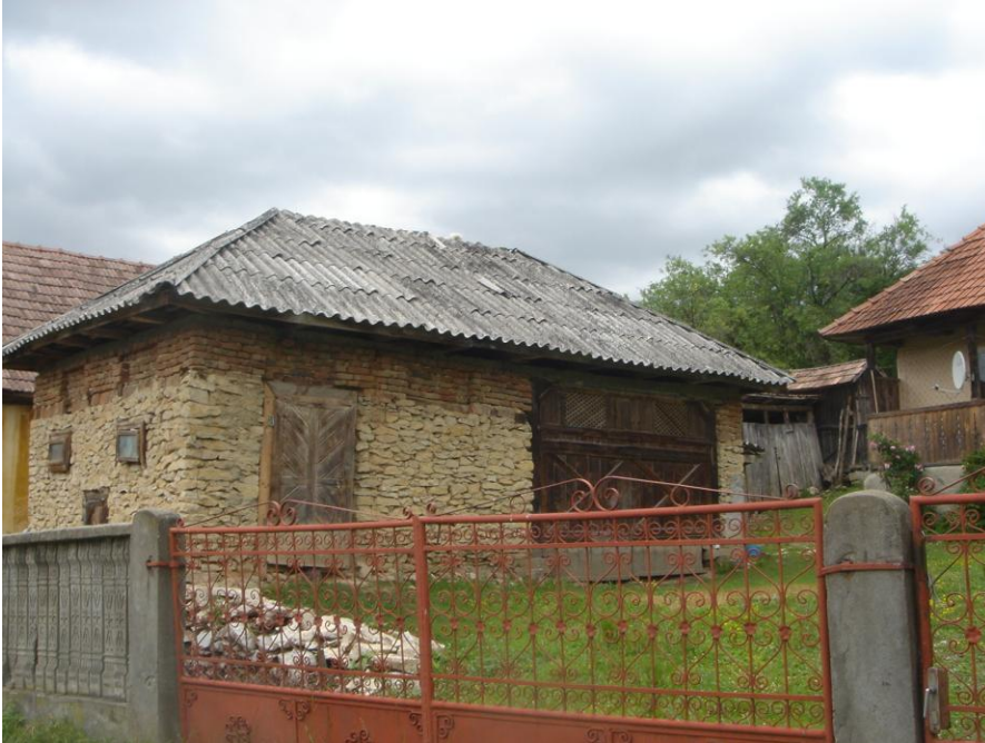
Anexa casei de la nr. 52-sat Piroșa; din păcate și aici învelitoarea a fost înlocuită cu plăci din azbociment.
