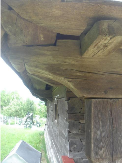
Detalii de îmbinare în lemn, cuie din lemn, dovezi ale măiestriei meșterilor locali care au înfruntat timpul
