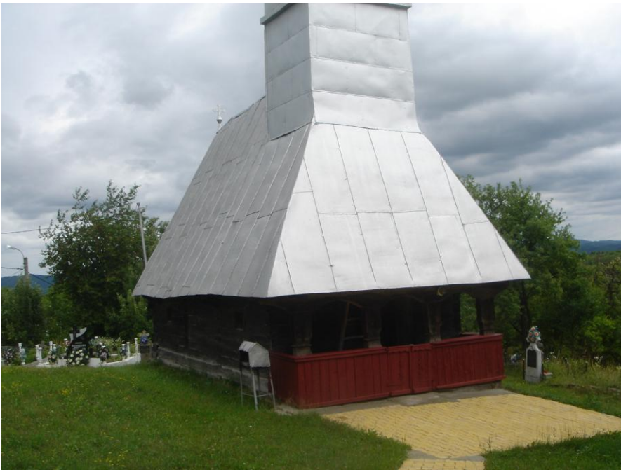
Învelitoarea din tablă, vopseaua stridentă a parapetului de prispă, reparațiile ușii de la intrare și dalajul strident prefabricat, toate sunt elemente străine de natura monumentului care parcă ascuns de o mască de protecție participă la un “bal mascat al trecerii timpului”.
