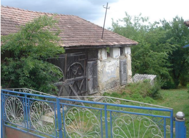
Gospodăria situată vis-a-vis de gospodăria nr. 77 a preluat la porţi în mod fericit decoraţiile specifice anexelor agricole. Intervenţiile ulterioare la gard (baluştri) şi acoperişul casei (plăci de azbociment cu efect cancerigen) oferă soluţii nepotrivite.
