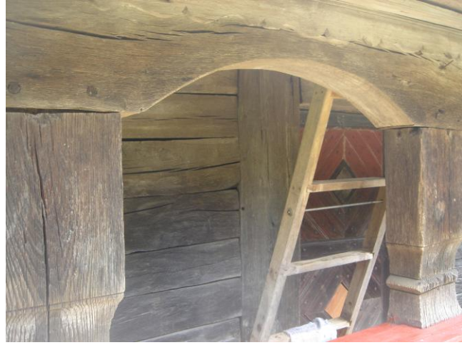
Detalii de îmbinare în lemn, cuie din lemn, dovezi ale măiestriei meșterilor locali care au înfruntat timpul
